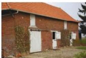
Exemple de toiture traditionnelle respectant les 20 éléments au M<sup>2</sup> (charte architecturale du Vexin Normand) : ardoise, petite tuile ou tuile mécanique
